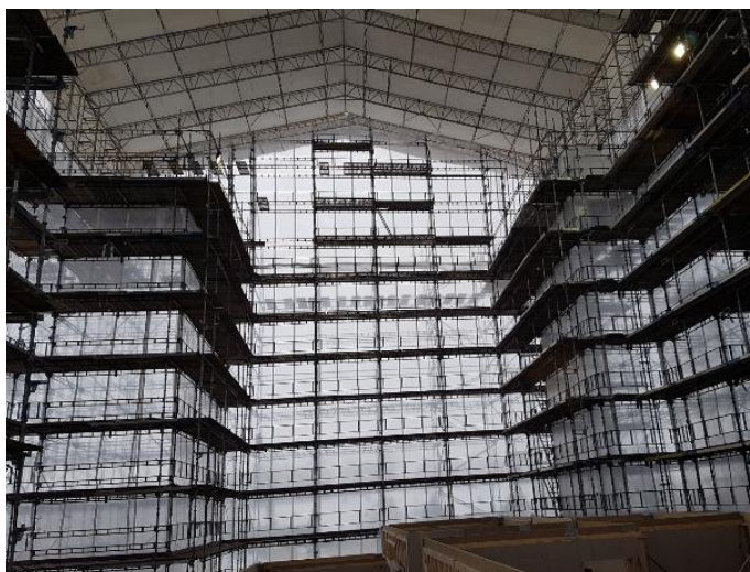
Figur 17: Fristående ställning som byggs till fullhöjd med fast tak, källa: Haki
