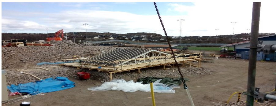
Figur 16: Provisorisk takkassett, källa: Skanska
