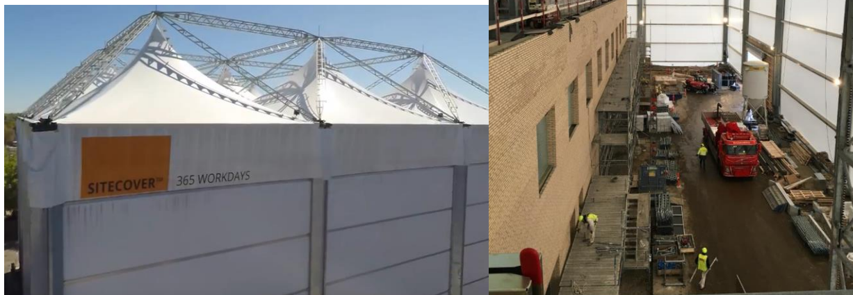
Figur 20: Helintäckt byggarbetsplats eller tälthall, källa: Sitecover
