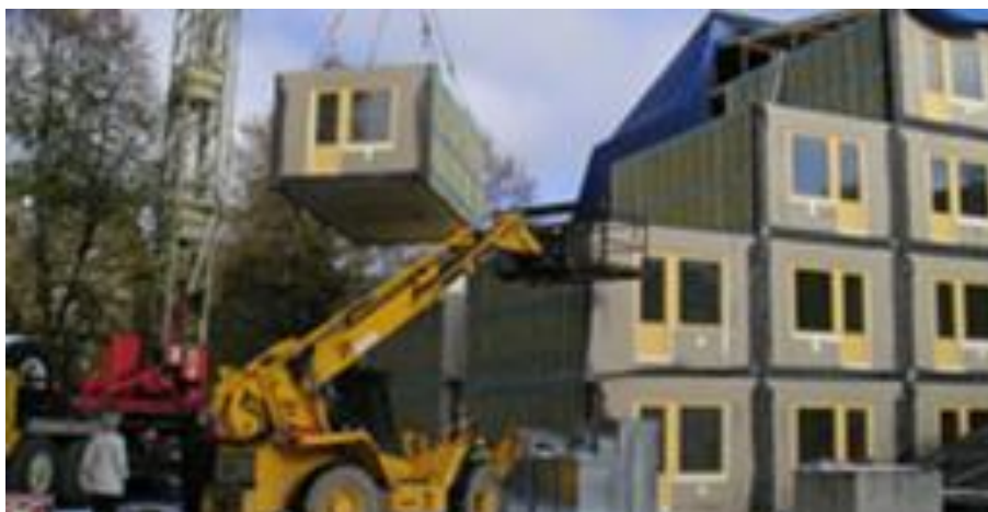
Figur 23: Provisoriskt väderskydd med hätta/presenning där tak/fasad inte är klart, källa: Träguiden, foto Hans-Eric Johansson
