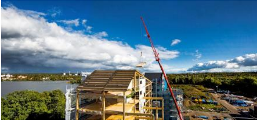
Figur 22: Stomme byggs till fullhöjd, väderskydd direkt därefter, källa: Advantage-Environment.com
