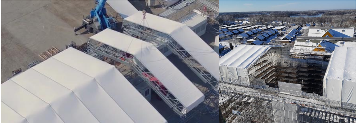
Figur 18: Fristående ställning som byggs till fullhöjd med öppningsbart tak, källa: Peri/Haki
