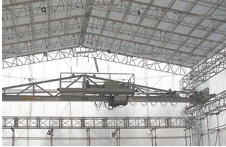
Figur 9: Travers i väderskydd, källa: Träguiden
