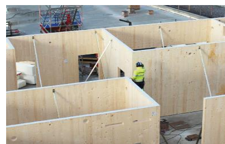
Figur 28: Massivträsystem, Foto: Per Karnehed ur Husbyggaren nr 3, 2017
