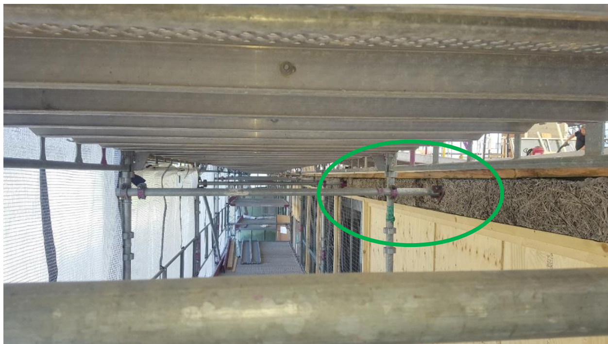
Figur 12 Exempel på förankring av väderskydd i byggnad från TBS, Tekniska Byggnadsställningar. Dimensioneringen av förankringen är mycket viktig.
